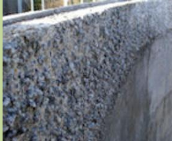
Fig. 2 : vue interne d'un digesteur en béton
