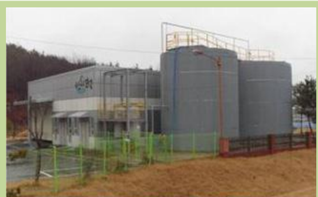
Fig 11 : usine biogaz de Bosing
