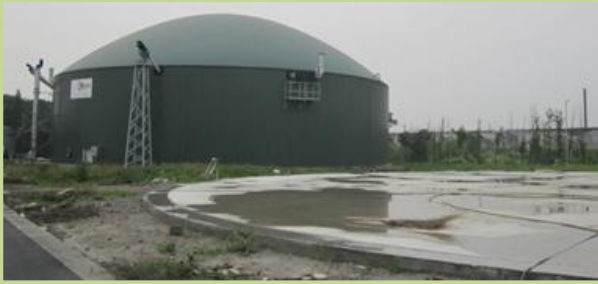
Fig 9 : Digesteur « Wuxi Kaiopu CNG System »
