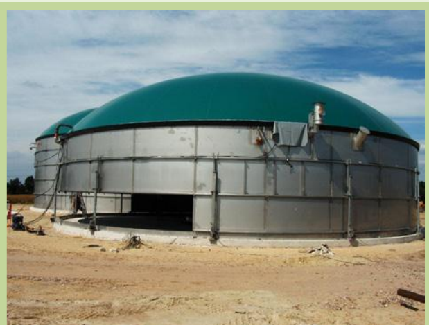
Fig.3 : construction d'un digesteur en acier inoxydable
