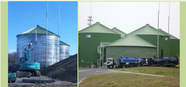
Fig : 12 : Digesteur n inox de « Shinko Bio Arc
