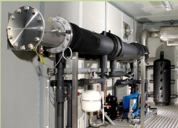
Fig. 7 : Exemples de déshumidificateur de biogaz
