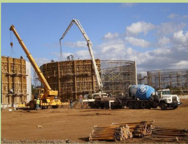
Fig. 1 : Construction d'un digesteur en béton
