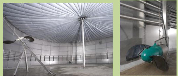
Fig 6 : vue intérieure d'un digesteur en inox
